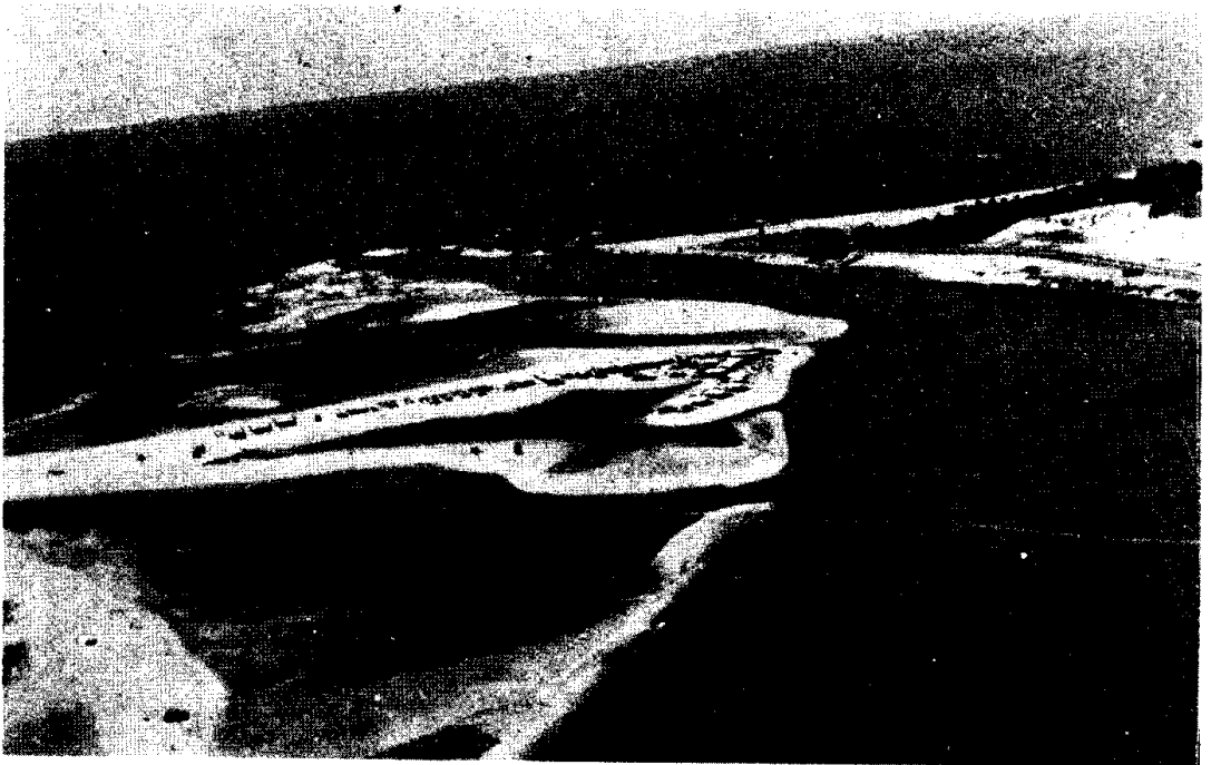
Figura 15 — Comportamento da embocadura do Rio Ceará após a construção dos espigões de proteção à margem direita do rio.
