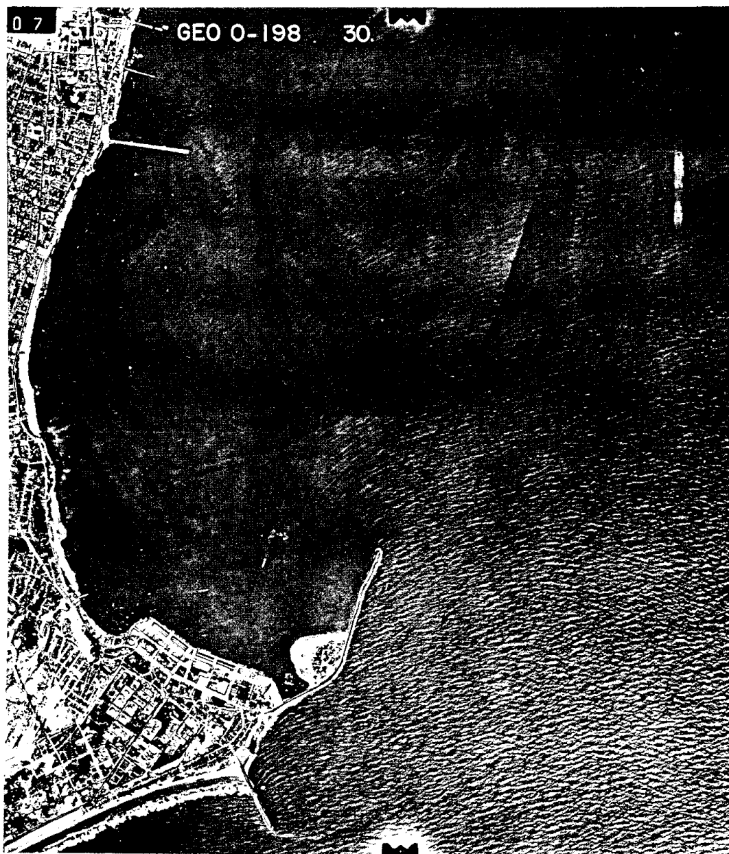
Figura 19 — Redistribuição do material depositado na parte interna do molhe, depois da implantação do espigão de retenção na Praia do Futuro.
